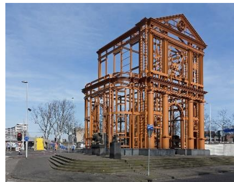
Figuur 7 Gereconstrueerde Nieuwe Delftse Poort Rotterdam
